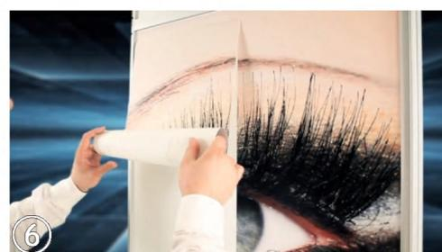
Nachdem die erste Bahn verklebt wurde, ist bei den folgenden Bahnen ständig auf den korrekten Abstand zu achten.
