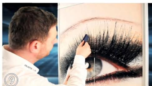
Die einzelnen Bahnen sind mit 1 cm Überlappung hergestellt. Vinyl ist ein Material, dass abhängig vom Untergrund, von der Lufttemperatur oder Feuchtigkeit, mehr oder Weniger arbeitet. Um das Entstehen von Risse oder Lücken zu vermeiden, arbeitet man mit der Überlappung.
